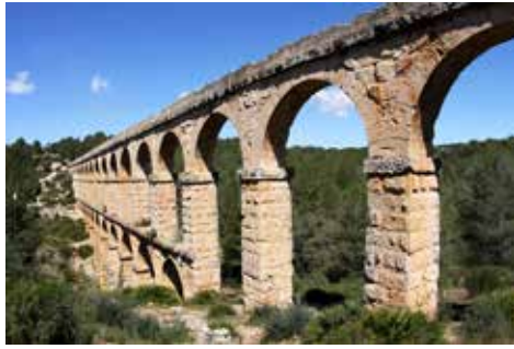
Pont del Diable. Acueducto romano cerca de Tarragona
